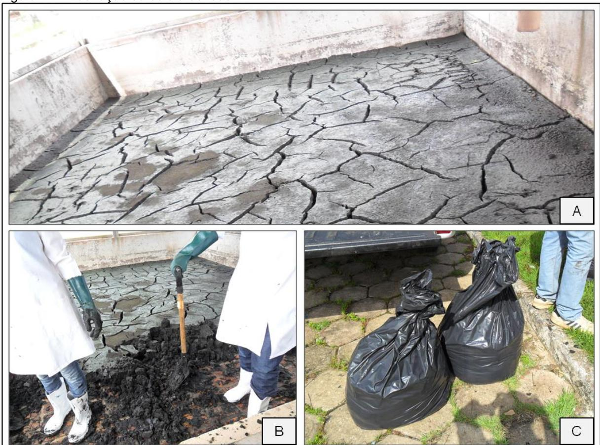
\***Legenda:** A) Disposição do lodo no leito no leito de secagem; B) coleta do lodo residual; C) armazenamento do lodo em sacos plásticos.
